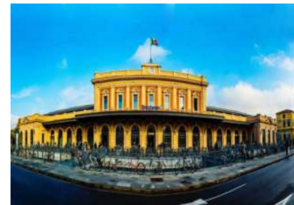
Железнодорожный вокзал Пармы, Италия (Были установлены 10 эскалаторов)
